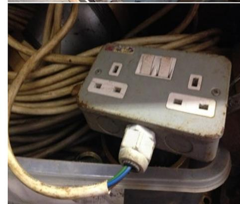
**X** 電纜終端應固定住。電纜護套應固定在終端內——單根電線/導線不應裸露在外，接線盒亦不應用膠帶固定。
