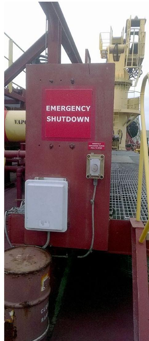
✓ 紧急关机按钮和急停按钮注有明确标识。
