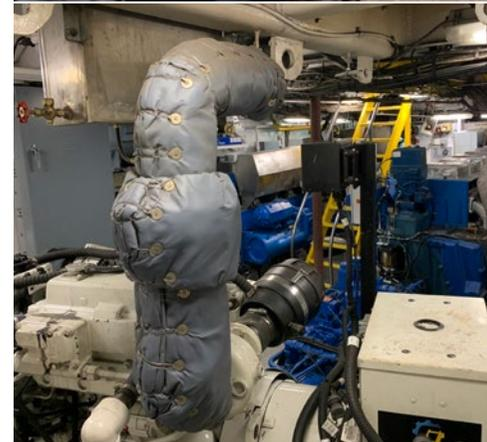
**✓** 隔热材料处于良好的无油状态，紧密贴合，无暴露出热表面的缺口。
