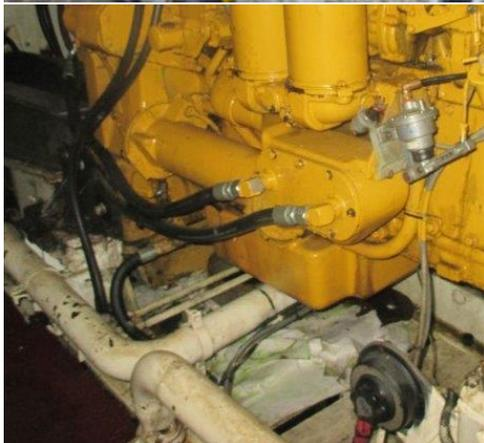
**X** 漏油问题应尽快纠正。浸油的吸油垫会增加火灾风险
