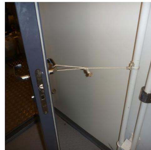
**X** 隔火舱壁的自闭式防火门在不使用时不应固定成打开状态。
