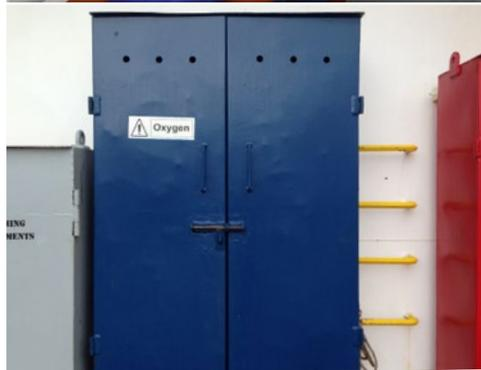
✓ 气割/气焊气瓶（乙炔/氧气）和任何家用燃料气瓶安全存放在起居舱室外有防护且通风之处。对于燃气管网系统，按照认证安装方式使用安全装置。
