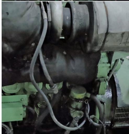
**X** 浸油的隔热材料应更换
