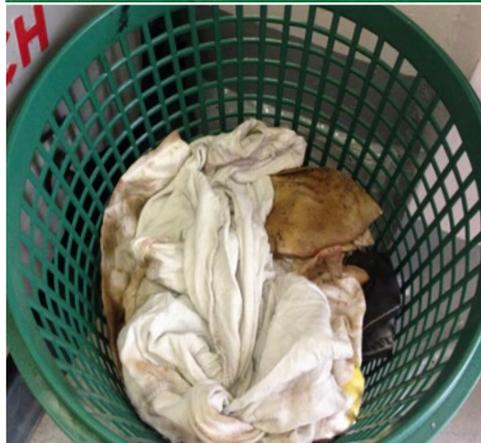
**X** 机舱内应无可燃材料和垃圾。垃圾桶应为带盖金属桶。油污抹布只能放在带盖金属桶内。
