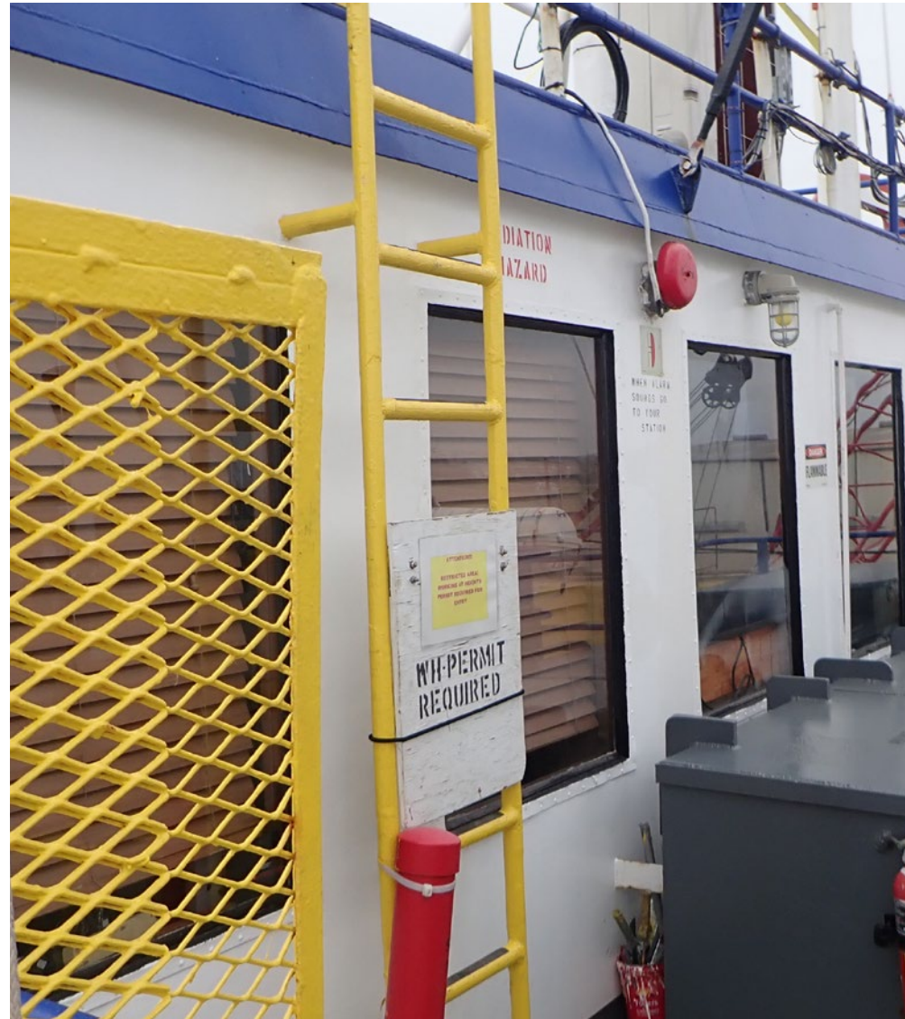
被作業許可證標誌牌擋住的固定式梯子、作業許可證格式範例、張貼的有效許可證。
