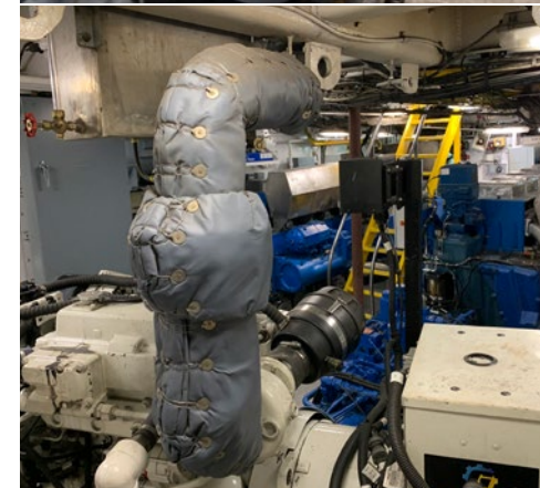
✓ 隔熱材料處於良好的無油狀態，緊密貼合，無暴露出熱表面的缺口。
