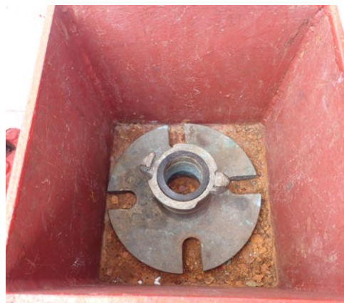
X 國際通岸接頭沒有用墊片螺栓、螺母和墊圈連接在一起。
