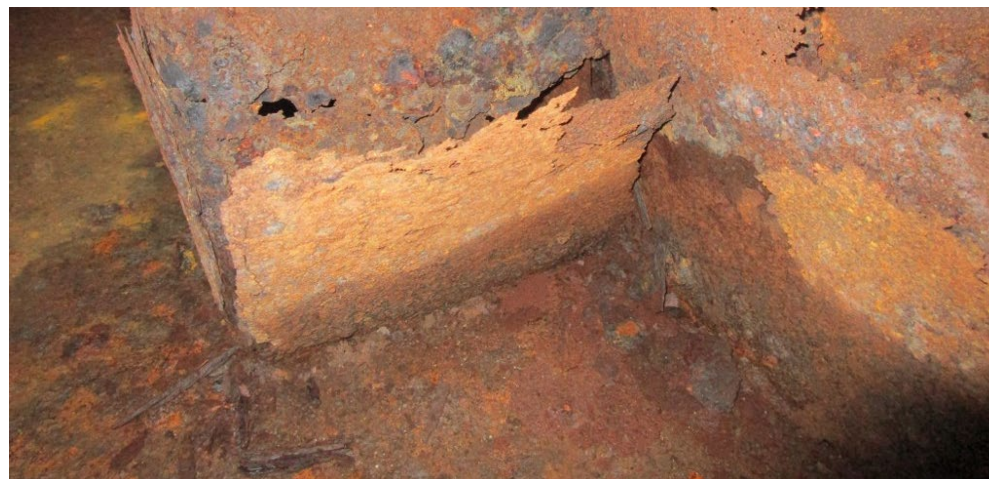
X 良好保養的設備可能看起來狀況良好，但如果任由甲板和底部結構磨損，設備也可能會從甲板上脫落。
